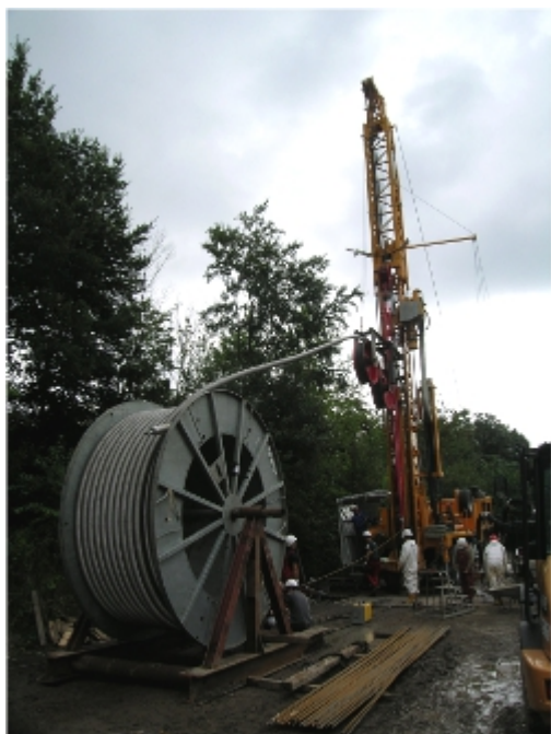
Einbau des Edelstahlwellrohrs beim Projekt Nienburg. Foto: GeoDienste
