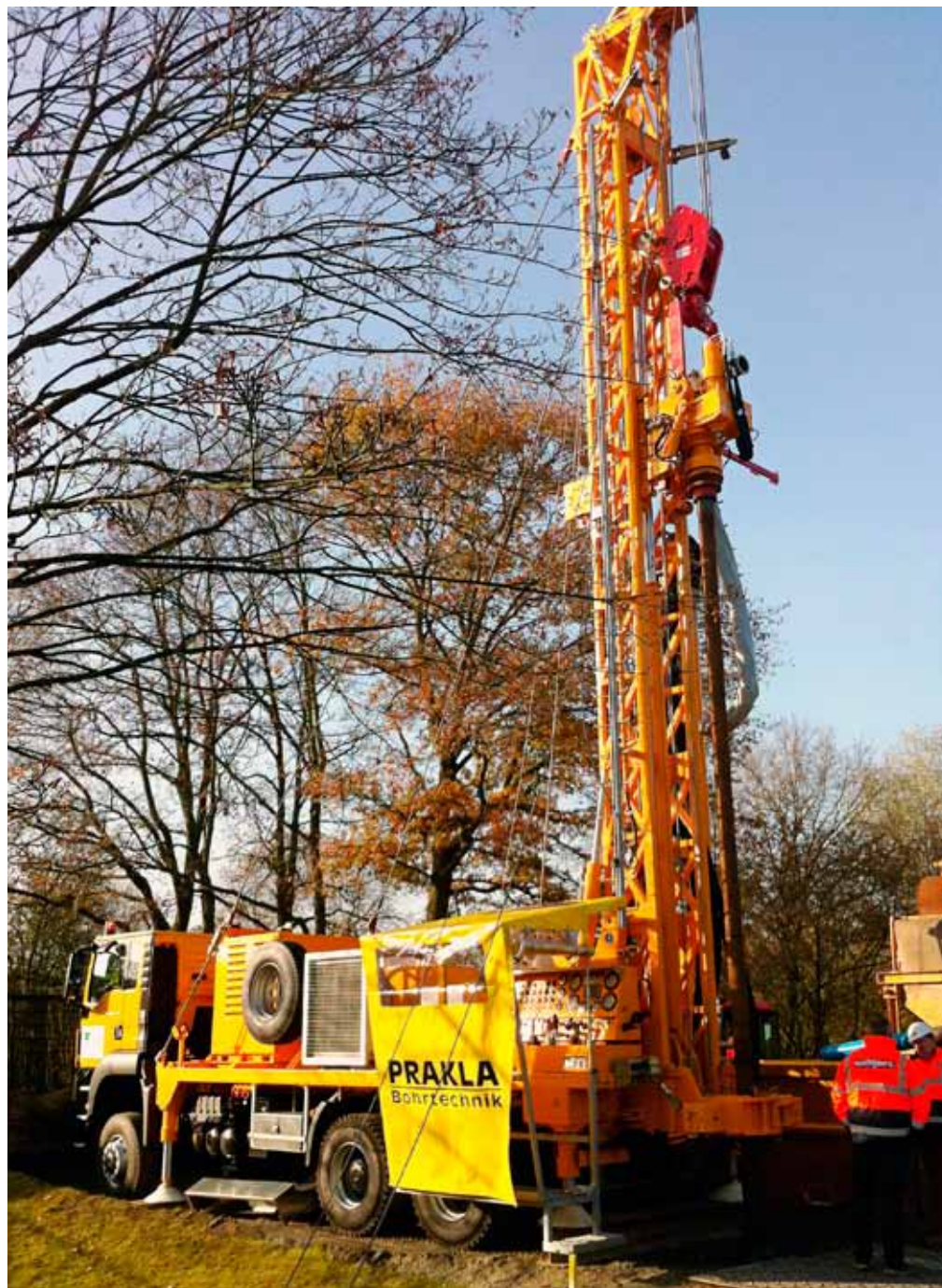
▲ Abb. 1: Bohranlage mit 50 t Hakenlast bei der mitteltiefen Geothermiebohrung am Nettebad in Osnabrück
